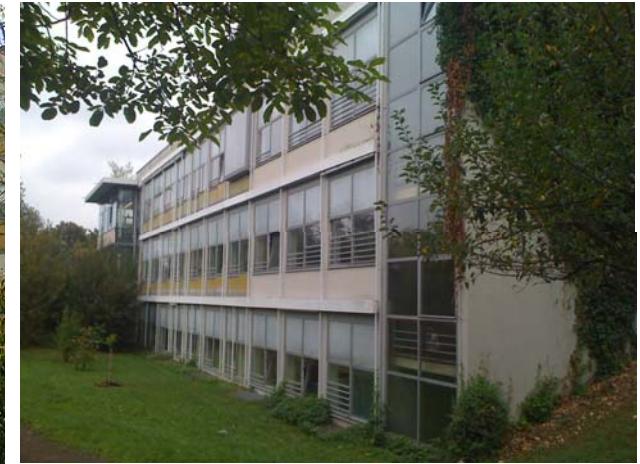
Südfassade Nebenhaus Fachklassen
