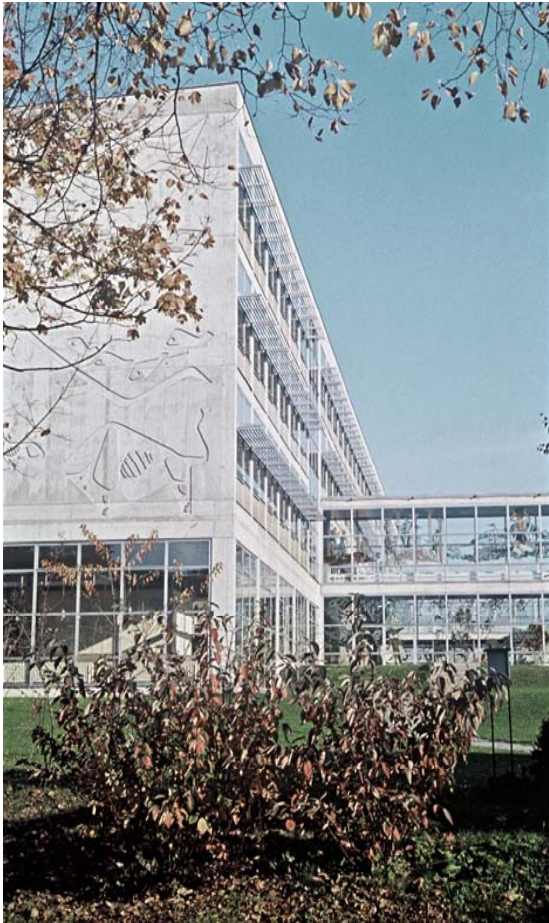
Westfassade mit Betonrelief
