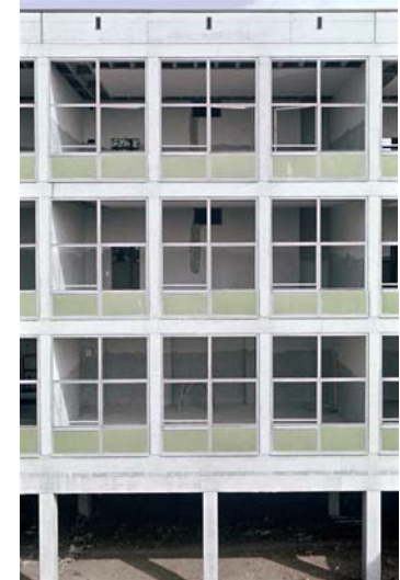
Schulgebäude im Bau
